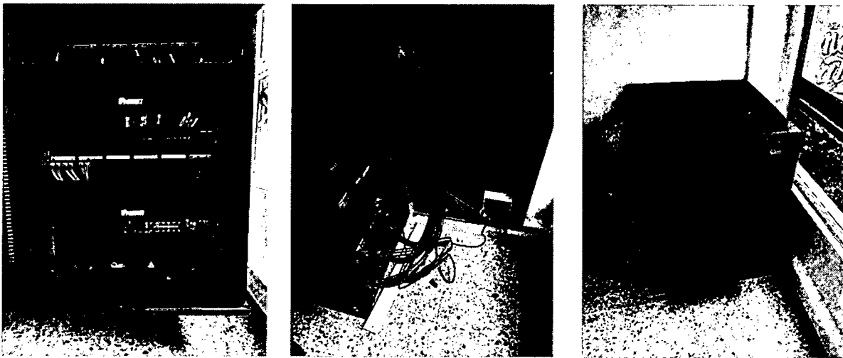
Imágenes 11,12 y 13. Gabinete con sus patch pannel y organizadores.
