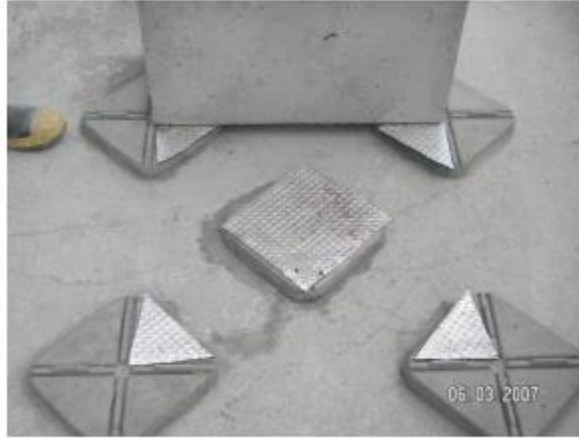
El trozo de manto de nivelación va en el apoyo central y en los apoyos esquineros.
